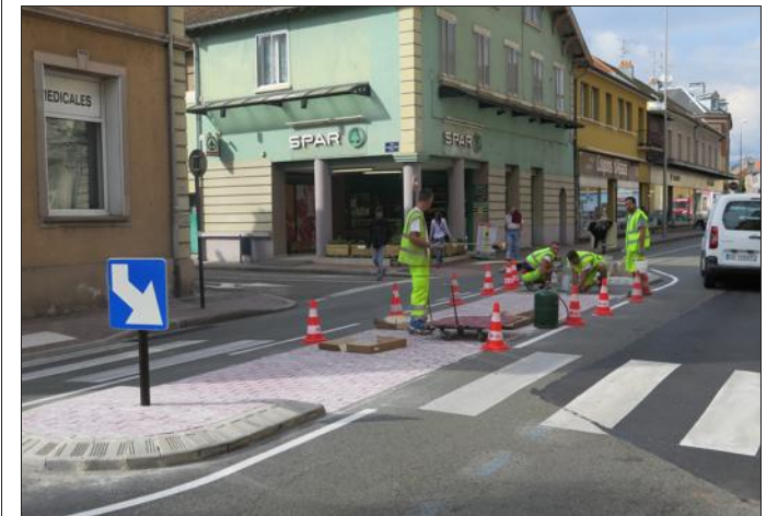
■ Des refuges ont été aménagés devant Spar.
